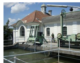
Kleinwasserkraftwerk Ungarfeld © EVN
